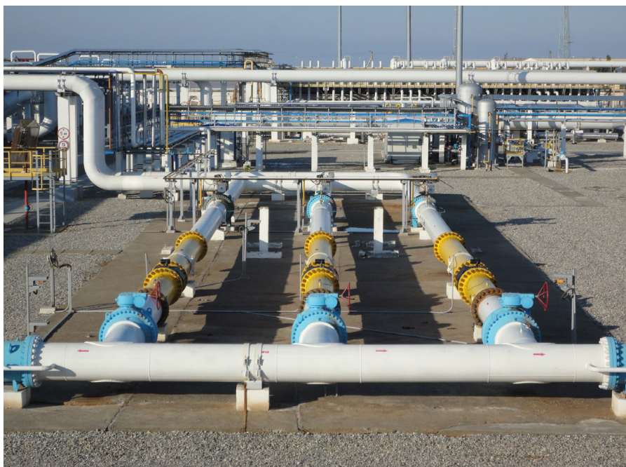
Рис. 3. Ультразвуковые измерительные комплексы «Вымпел-500» Ду 700 на ДКС «Шуртан» (Узбекистан)
